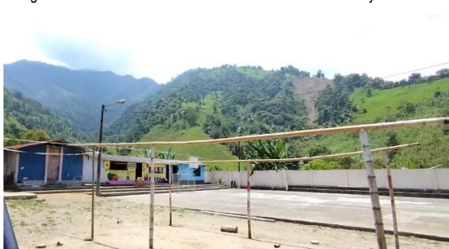
Fotografía 171. Deslizamiento cerca de la Escuela 24 de Mayo en el Guadal
