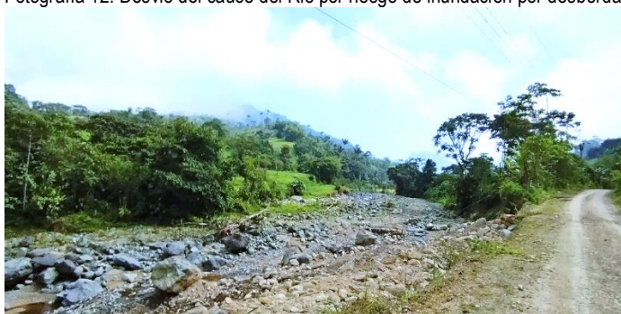
Fotografía 12. Desvió del cauce del Rio por riesgo de inundación por desbordamiento del Rio Cristal
