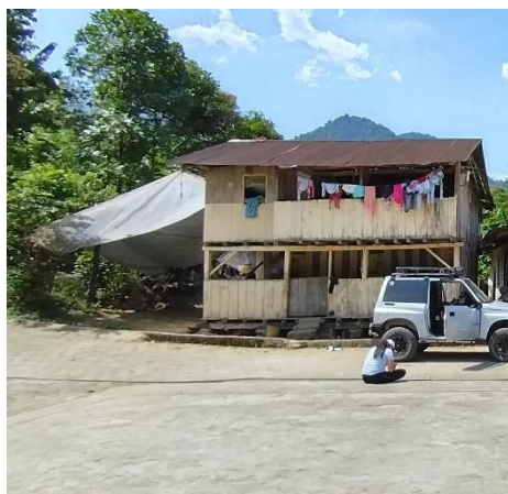
Fotografía 19. Fotografía Vivienda con techos de zinc y paredes de caña
